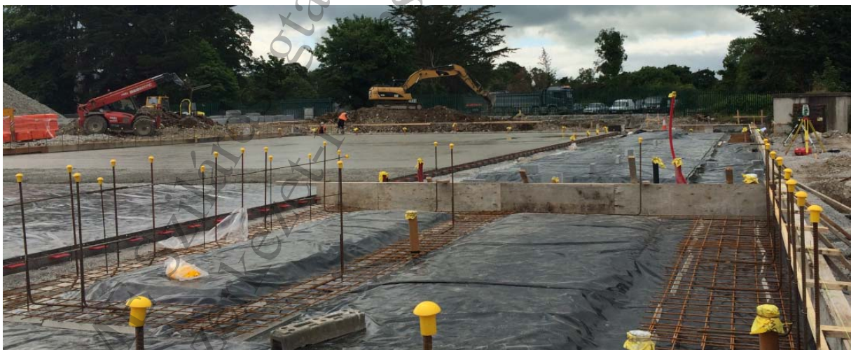
1. ábra: Ipari padló építés közben
